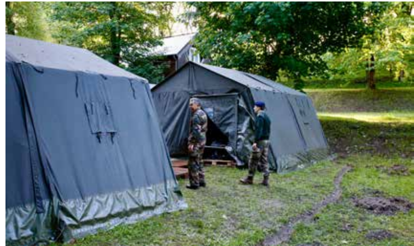
■ Rigoles creusées pour permettre l'évacuation des eaux
